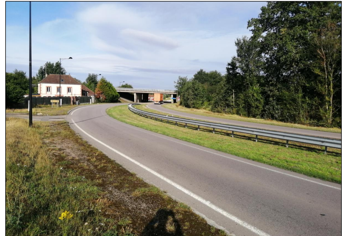
Figure 6 : Vue n°1 (Source : Egis, 13/08/2019)
