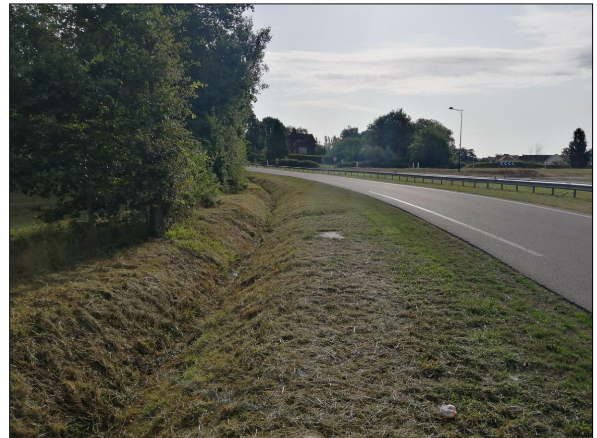
Figure 7 : Vue n°2 (Source : Egis, 13/08/2019)
