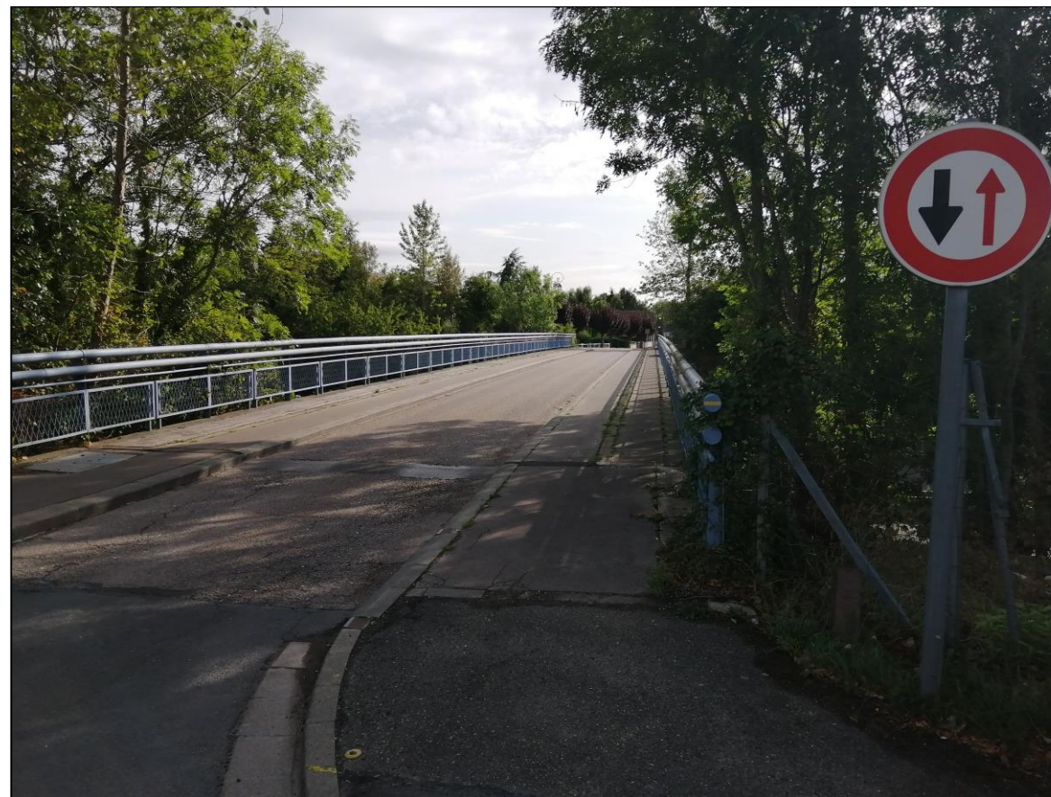
Figure 10 : Vue n°5 (Source : Egis, 13/08/2019)
