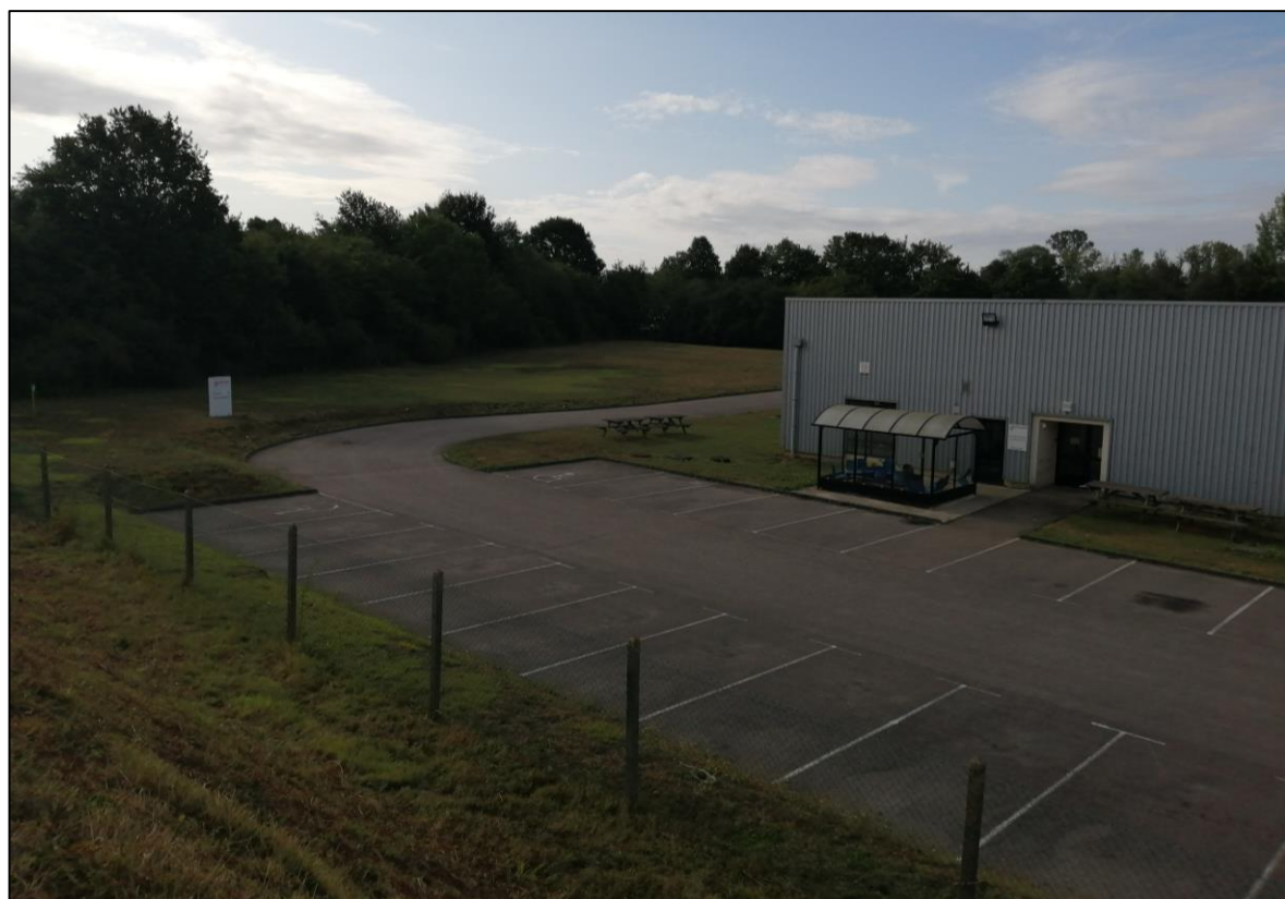
Figure 9 : Vue n°4 (Source : Egis, 13/08/2019)
